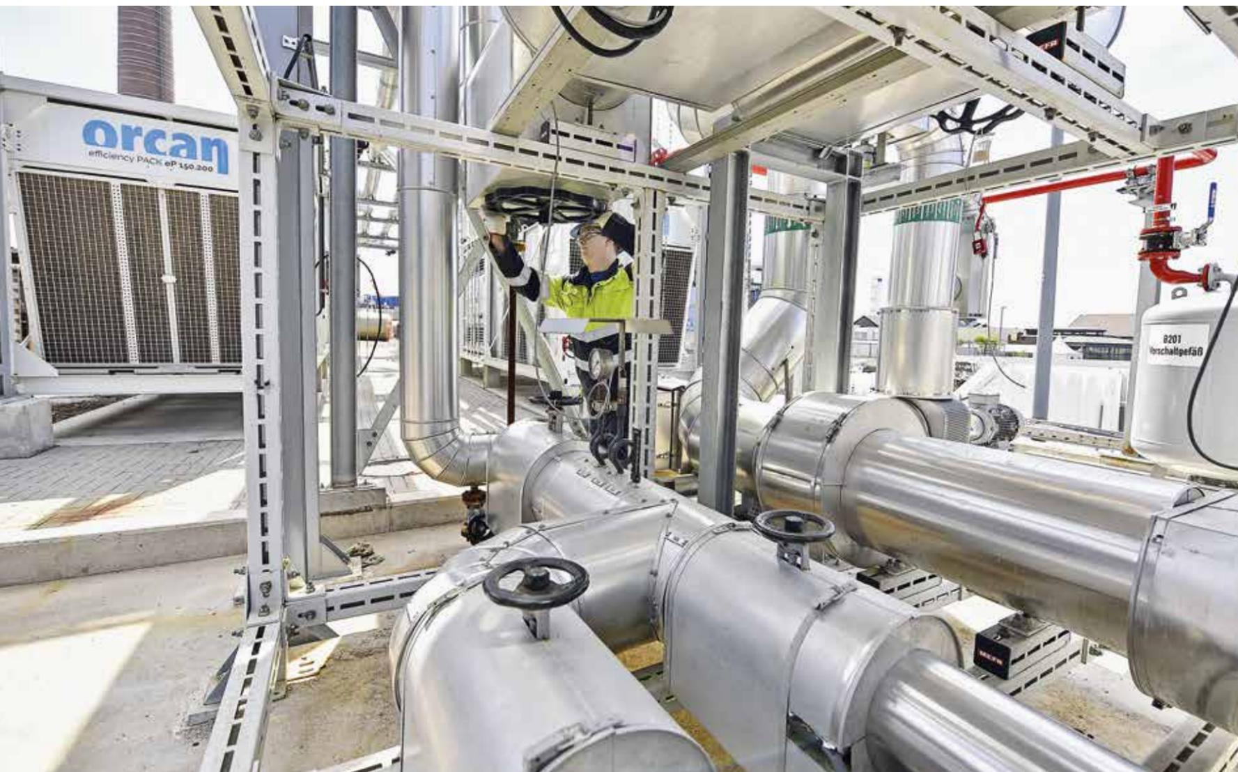
**VOLLES ROHR:** Instandhaltungsmeister Christoph Lübben öffnet ein Dampfventil der neuen Anlage zur Nutzung der Abwärme.
