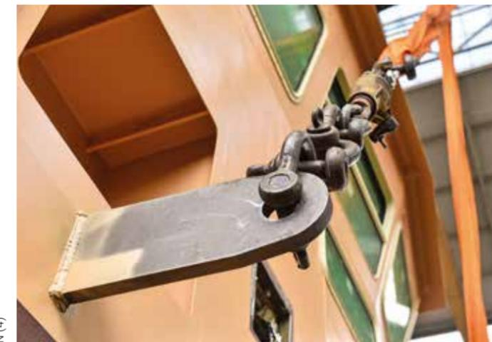
**AUFHÄNGUNG:** Um den schweren Decksaufbau mit dem Kran auf den Schiffsrumpf heben zu können, wurden vorher Laschen angeschweißt.
