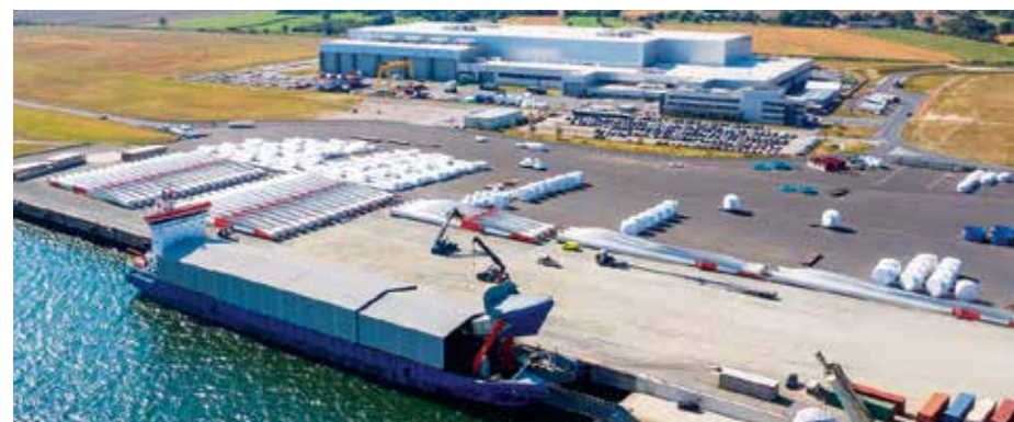
AN DER NORDSEEKÜSTE: Landstrom am Verladekai von Siemens Gamesa in Cuxhaven.
