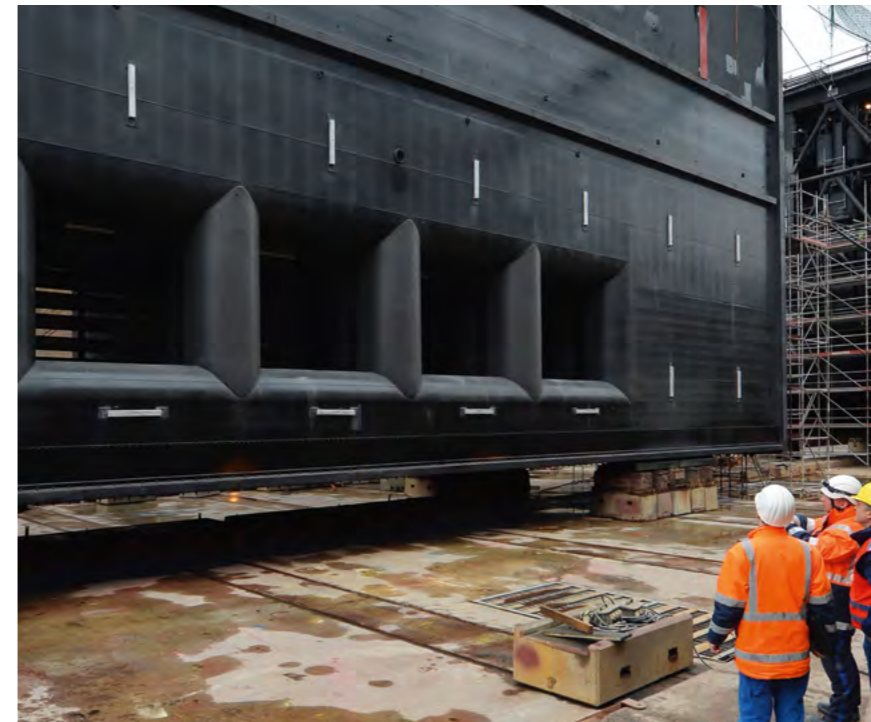
Das größte der drei Schleusentore hat eine Länge von 57 Metern. Der Transport ins Trockendock der Werft war ein aufwendiger Prozess, an dem mehrere Schlepper und Kräne beteiligt waren.
