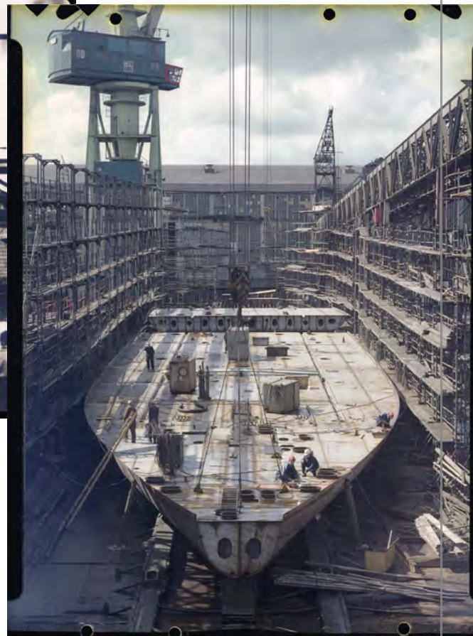
Ganz klassisch auf einer Helling – so wurden auf dem alten Gelände der Werft bis zur Wende vor allem Frachtschiffe gebaut.
