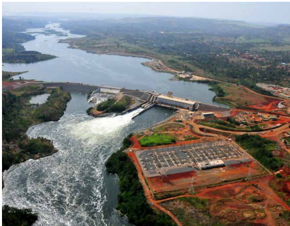
Wasserkraftwerk in Uganda (Quelle: Fichtner)
