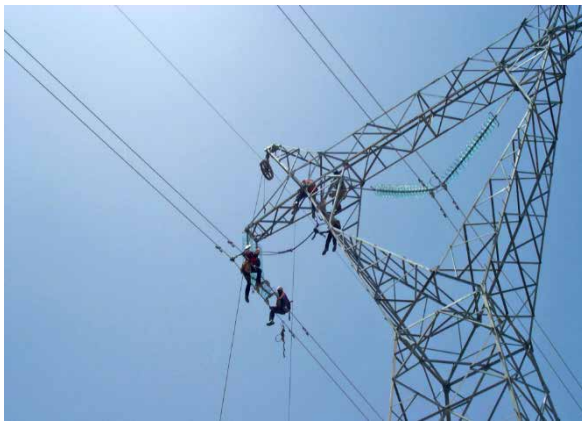
Wartungsarbeiten an einer Hochspannungsstromtrasse (Quelle: Fichtner)
