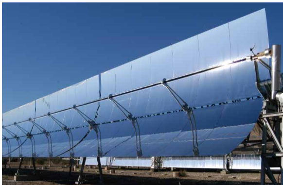
Parabolrinne eines Solarfarmkraftwerks (Quelle: DLR)
