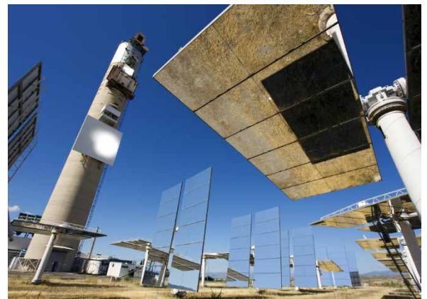
Heliostaten und Receiver-Turm eines solarthermischen Kraftwerks (Quelle: Thomas Ernsting/LAIF)
