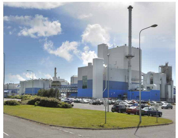
Biomassekraftwerk (Quelle: Siemens AG)
