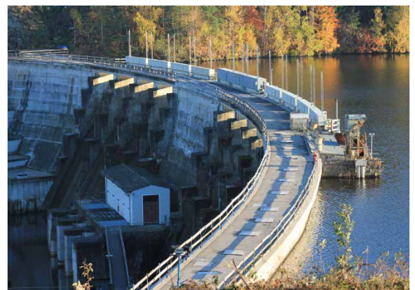
Staumauer eines Speicherwasserkraftwerks (Quelle: © Uwe Schlick/PIXELIO)
