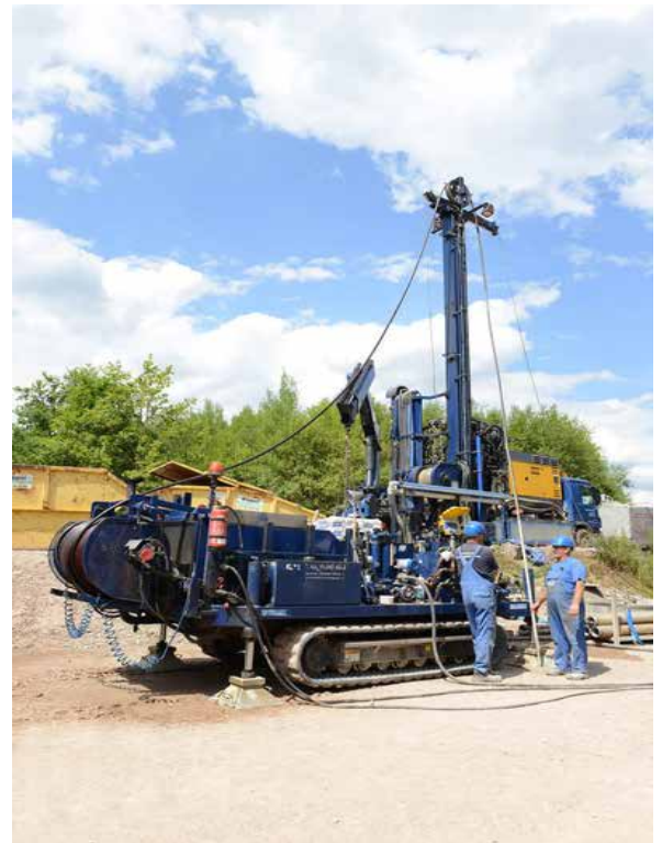
Bohrgerät zum Abteufen von Erdwärmesonden (Quelle: BWP)
