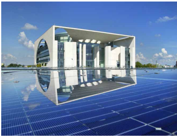
Fotovoltaikanlage im Bundeskanzleramt (Quelle: BSW-Solar/Langrock)
