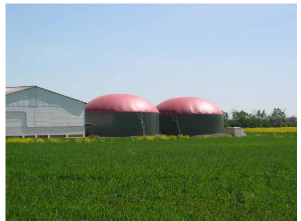
Fermenter einer Biogasanlage (Quelle: TUHH)
