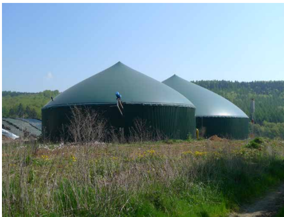
Fermenter einer Biogasanlage (Quelle: VDI)
