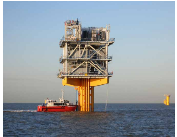
Umspannstation eines Offshorewindparks (Quelle: Siemens AG)
