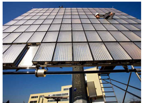
Nachgeführte PV-Anlage mit Konzentratormodulen (Quelle: Thomas Ernsting/LAIF)
