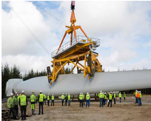
Montage des Rotors einer Windkraftanlage (Quelle: Siemens AG)
