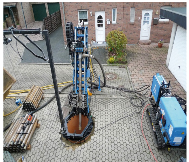
Erdwärmebohrung im Altbau (Quelle: BWP)
