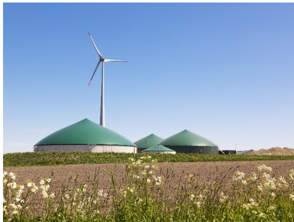
Fermenter mit Nachgärer (Quelle: Zukunft Erdgas e.V.)
