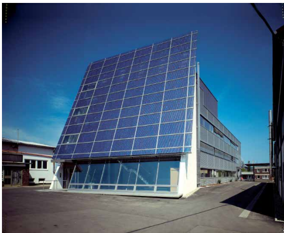
Fassade mit Fotovoltaikmodulen (Quelle: BSW-Solar/SMA)
