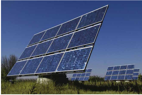
Nachgeführte polykristalline Fotovoltaikmodule (Quelle: BSW-Solar)
