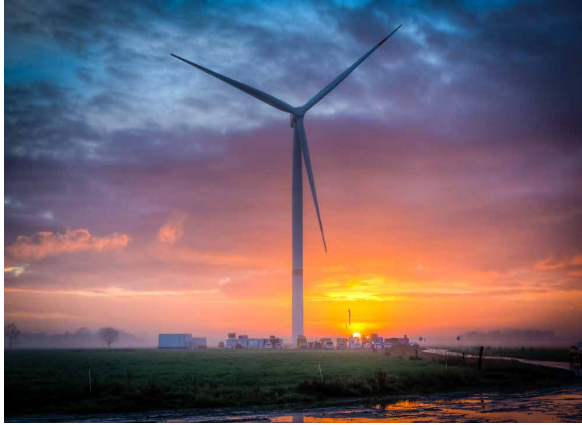
Onshorewindkraftanlage (Quelle: Siemens AG)
