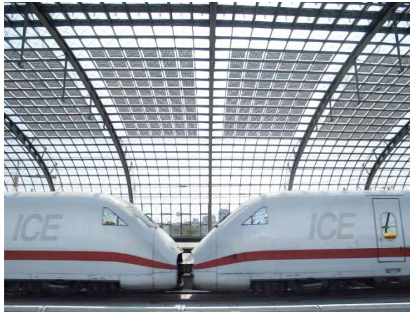
Fotovoltaiknutzung im Berliner Hauptbahnhof (Quelle: BSW-Solar/ Langrock)
